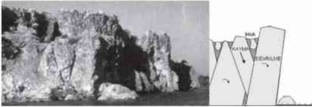
Şekil 10. Konyaaltı varyantında çoklu ikincil devrilme mekanizması (Dipova, 2003).
