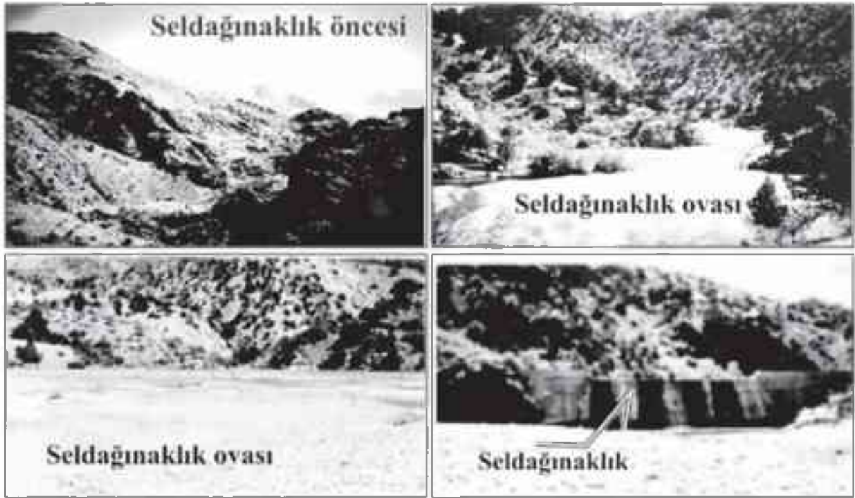
Şekil 2. Seldagimlik yapısı öncesi ve sonrası saha durumu (Kırkgeçit vadisi, Pozantı). Figure 2. The valley before and after the construction of an artificial dyke (Kırkgeçit valley, Pozantı).
